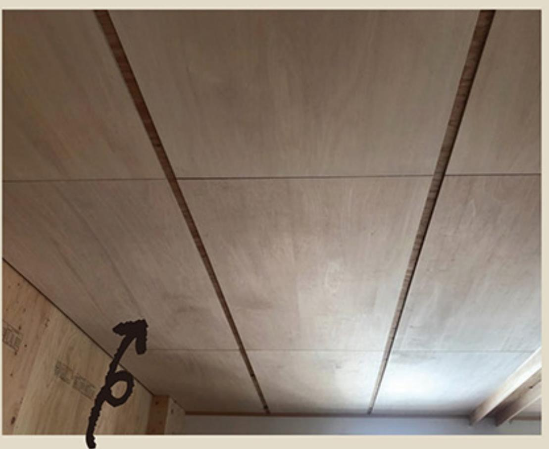
シナ合板の天井。板と板の間を、少し隙間を開けて目地を設け、空間的なラインを作っています。照明用ダクトレールが埋め込めるように造作しており、レールの段差が少なくなるよう設計しています。
